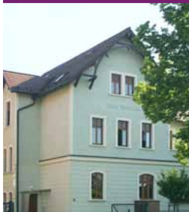
Standort Haus Bethesda Hoyerswerda
